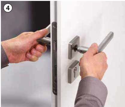
4 Kolları takın ve inbus civatayı sıkın
