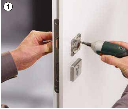
1 Alt konstrüksiyonu takın ve sıkıca vidalayın
