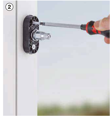
Alt konstrüksiyonu profile vidalayın
