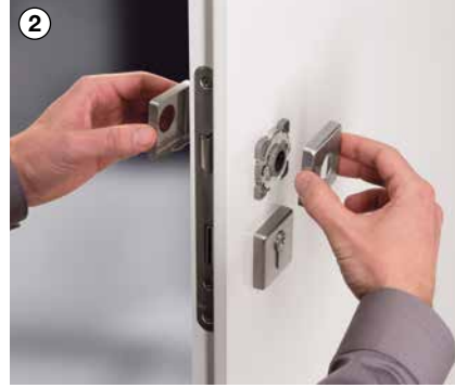
2 Rozetleri konstrüksiyon üzerine klipsleyin
