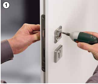
1 Alt konstrüksiyonu takın ve sıkıca vidalayın
